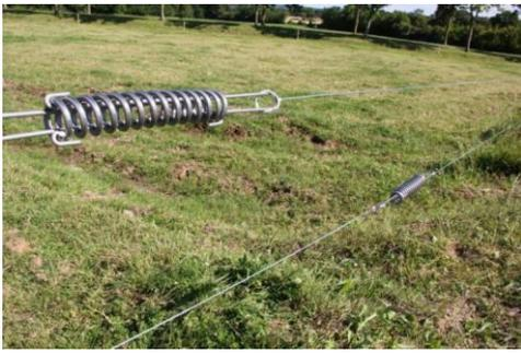
**La clôture équipée de conducteur high tensile** réduit considérablement le nombre de piquets lorsque les conditions sont propices. La mise en place de ce fil de clôture très tendu « high tensile » permet de ne placer qu'un piquet tous les 10 à 20 m mais demande cependant 2 à 3 fois plus de temps d'installation. En revanche, ce type de clôture offre une durée de vie de 40 ans, une grande résistance à la rupture et permet d'augmenter considérablement le débit du chantier de l'entretien.
